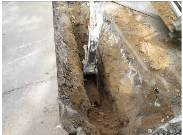
146. Obertura de la rasa
