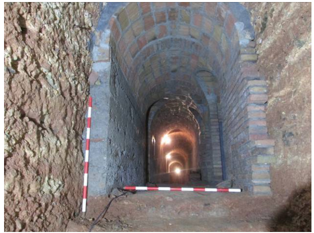
62. Extrem S del Tram 5, amb el mur esquerre d'encofrat de formigó, i el dret d'obra vista.
