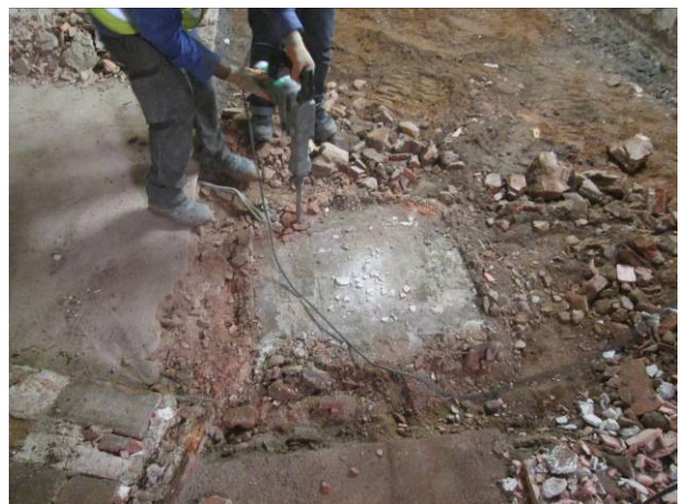
72. Treballs d'obertura del pou UE 8
