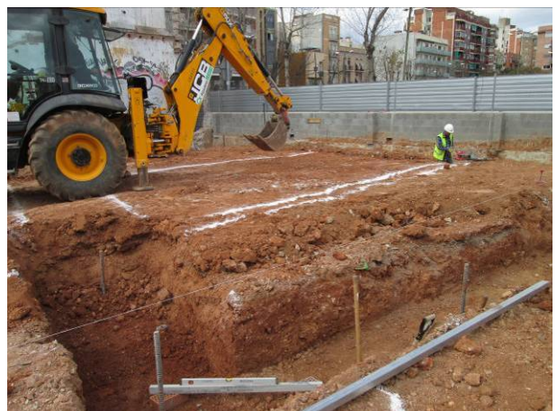
84. Obertura de la Rasa 5
