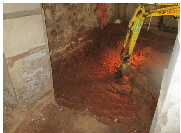
96. Rebaix a l'interior de la finca (UE 6)
