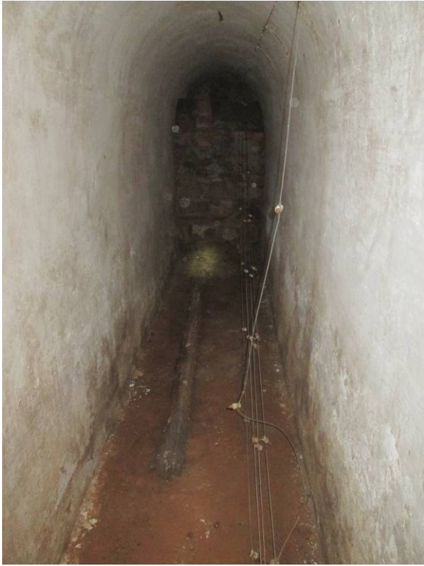
101. Interior de la galeria vers el S
