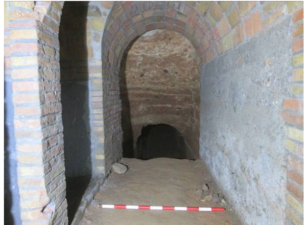
52. Extrem S del Tram 5 amb obra i inici del tram excavat
