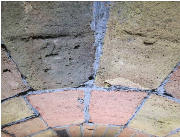
39. Marques del fabricant de maons al Tram 5
