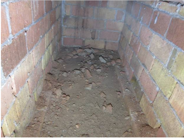
55. Interior de la fossa sèptica UE 24
