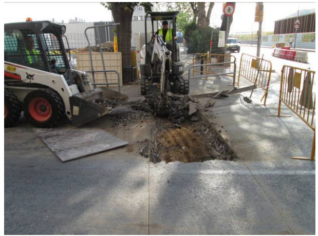
144. Obertura de la rasa a la vorera est.
