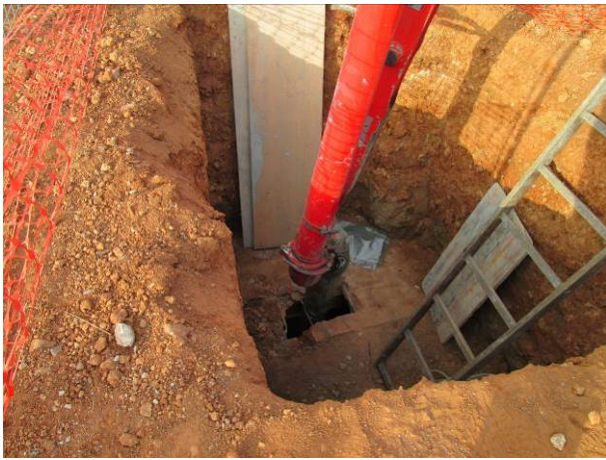
79. Entrada de la mànega per injectar formigó
