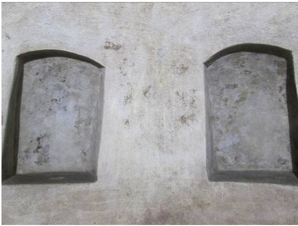
13. Fornícules centrals de l'àmbit Ue 12
