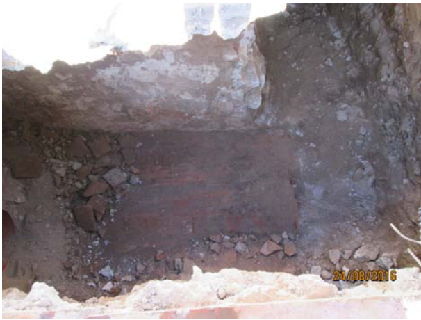
115. Murs UE 30, 31 i paviment UE 32
