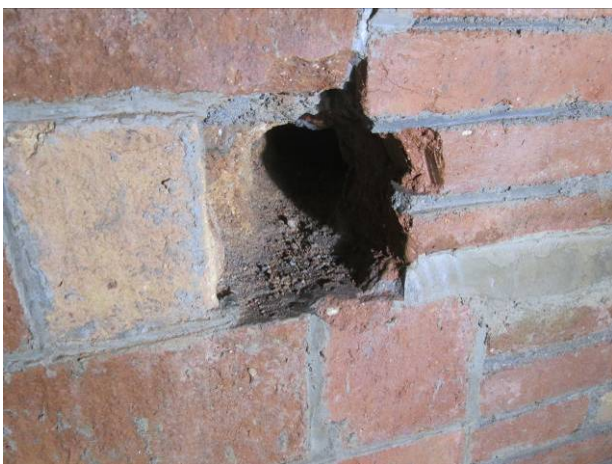
59. Orifici des del pou UE 13, per passar el tub vers la pica UE 17
