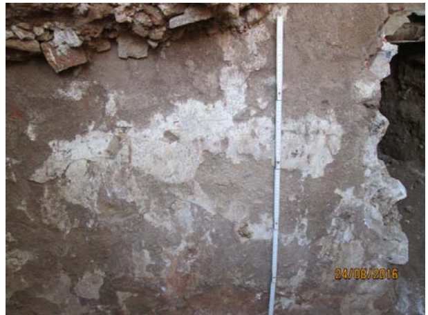
114. Parament E del mur UE 31
