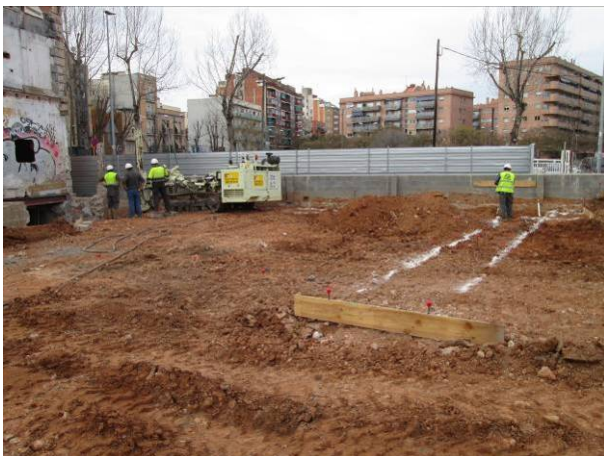
77. Inicis de la realització dels micropilots a la banda E
