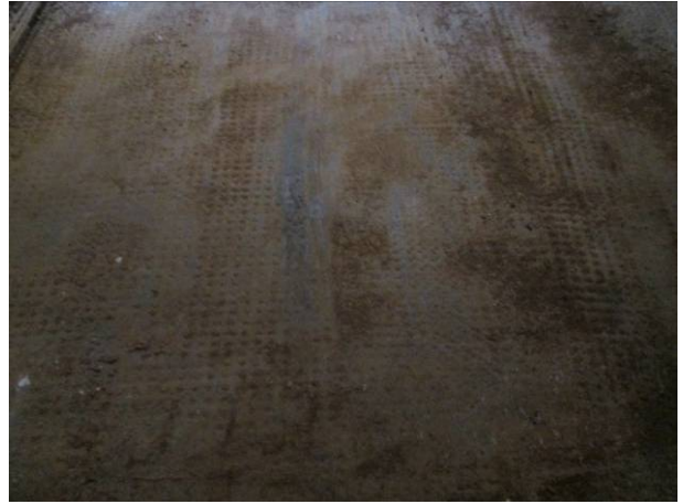
110. Paviment de ciment a rodet.
