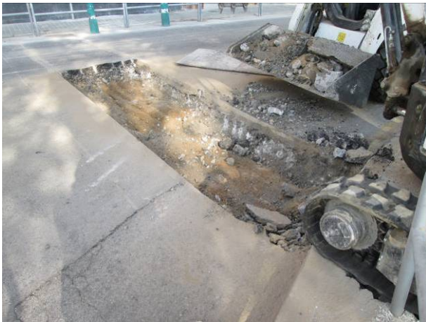
145. Retirada del paviment.
