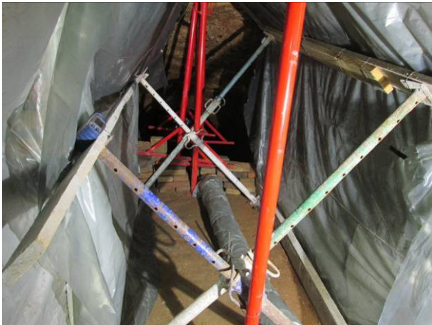
81. Protecció de l'estructura del refugi (UE 11)
