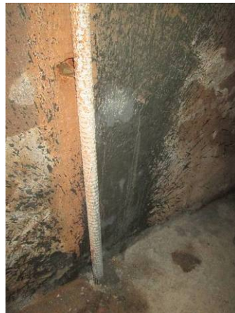
10. Perforació del micropilot al paviment del Tram 2
