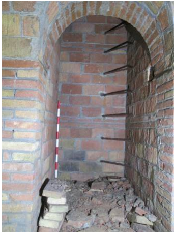
57. Pou de ventilació UE 13
