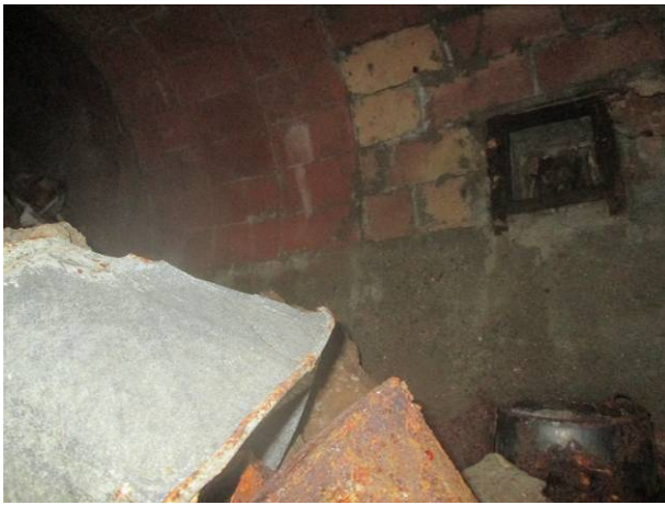
31. Interior de l'accés tapiat pel mur UE 22
