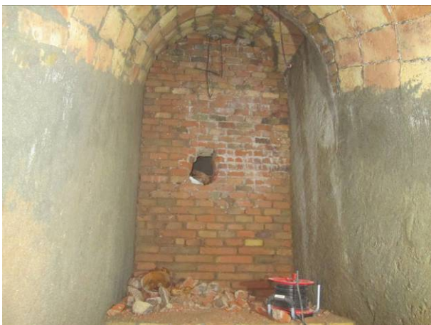
29. Mur UE 22, al Tram 6
