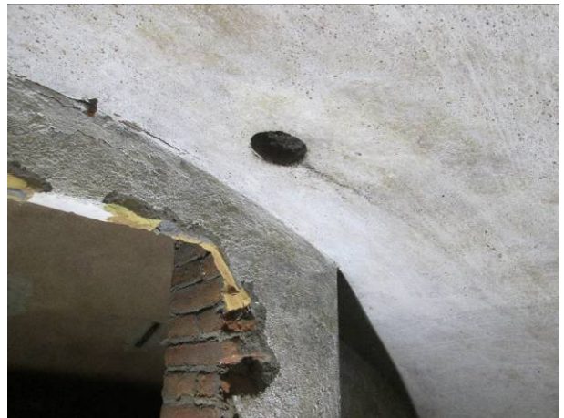
16. Orifici al sostre de l'àmbit UE 12
