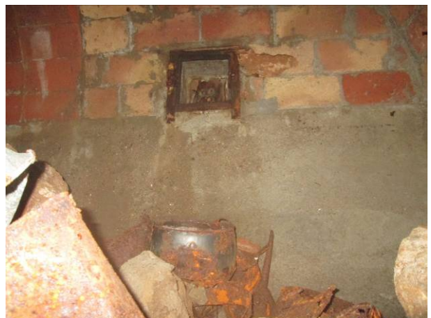
30. Interior de l'accés tapiat pel mur UE 22
