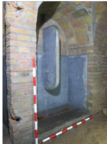
50. Vista general de l'urinari UE 16
