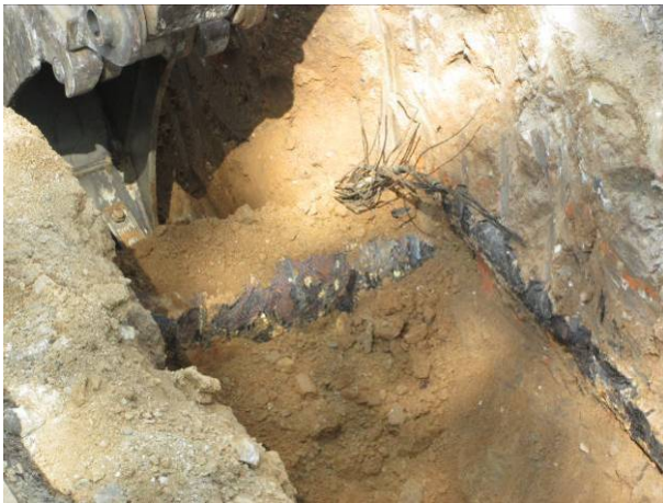
151. Perforació del micropilot a la paret S del Tram 2
