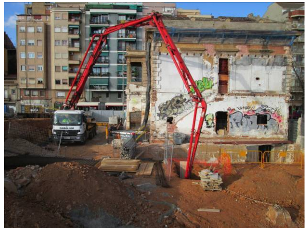
80. Treballs de rebliment del refugi
