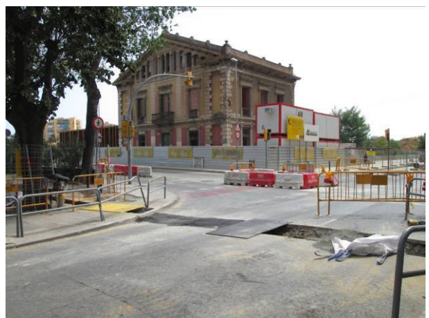
154. Finalització de la rasa, reposició asfalt
