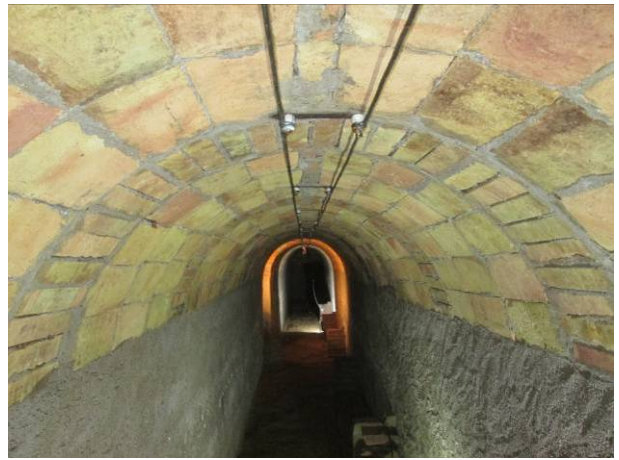
20. Instal·lació elèctrica a la banda E del Tram 4
