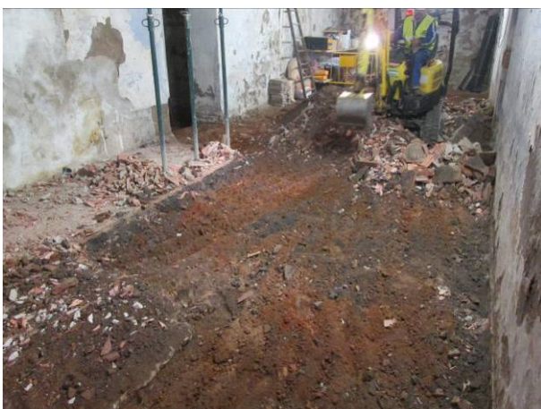
95. Retirada del paviment del soterrani. Vista de l'estrat UE 7
