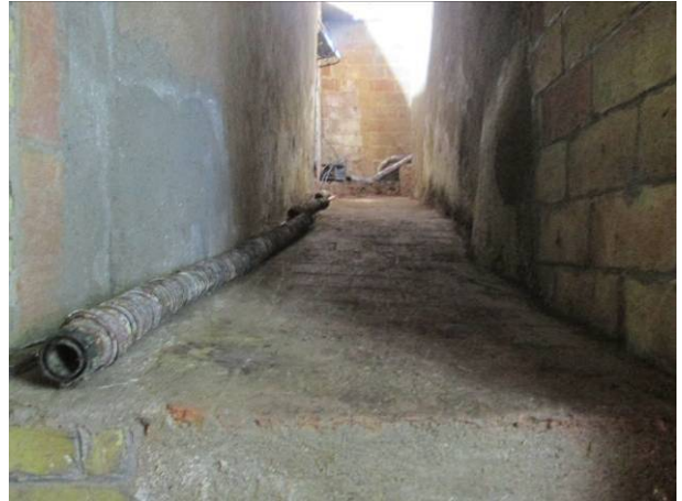
8. Detall del paviment al Tram 2
