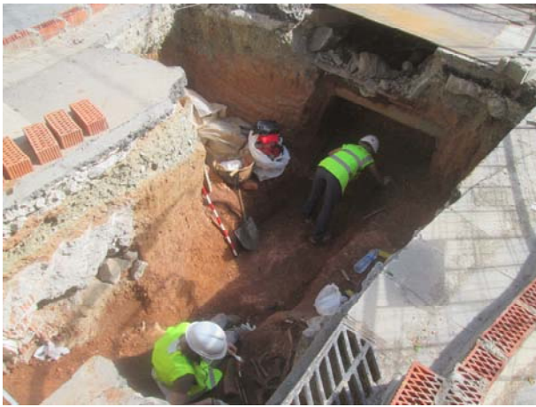
121. Inici dels treballs d'excavació de la necròpolis
