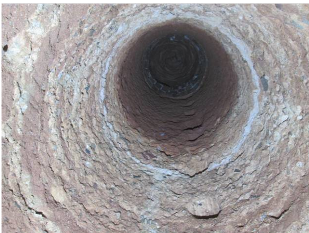
65. Pou excavat UE 18
