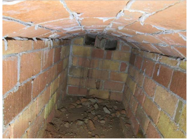
56. Interior de la fossa sèptica UE 24, amb els desaigües.
