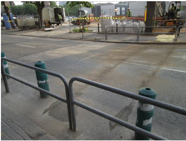
143. situació de la rasa al c. Berenguer de Palou núm 41
