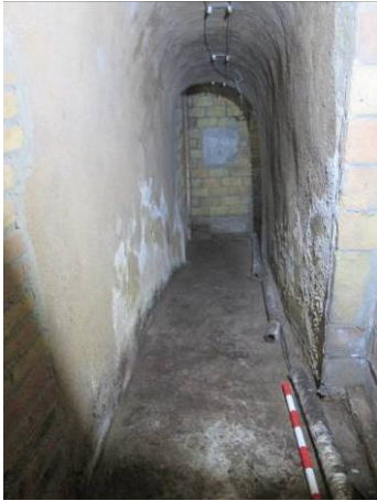
7. Galeria del Tram 2
