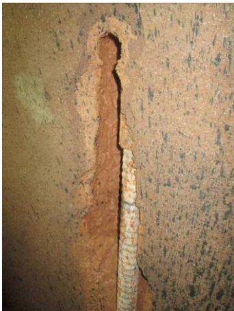
9. Perforació del micropilot a la paret S del Tram 2
