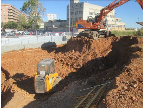
75. Rebaix a la zona E de l'edifici
