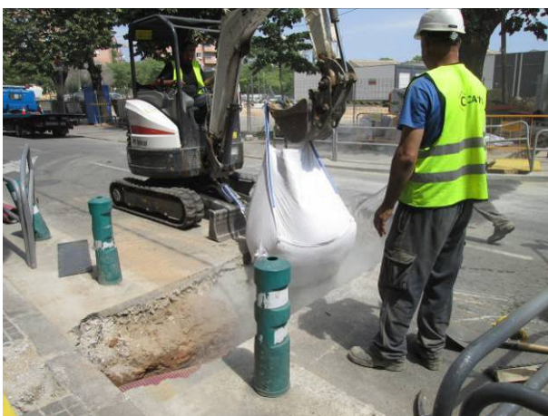
153. Cobriment de la rasa
