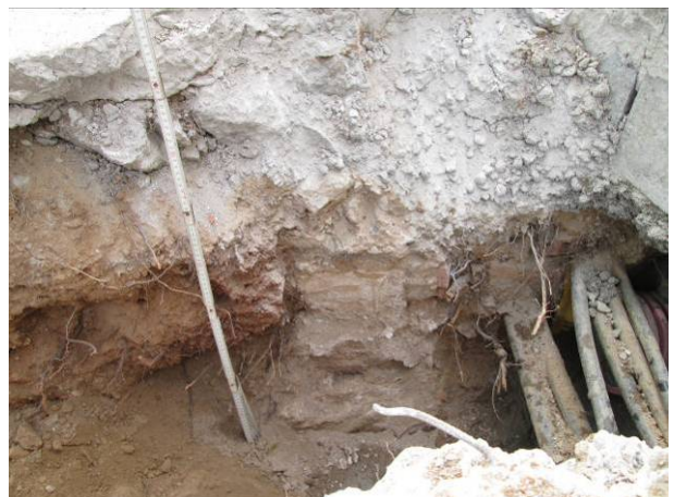
148. Mur localitzat UE 304
